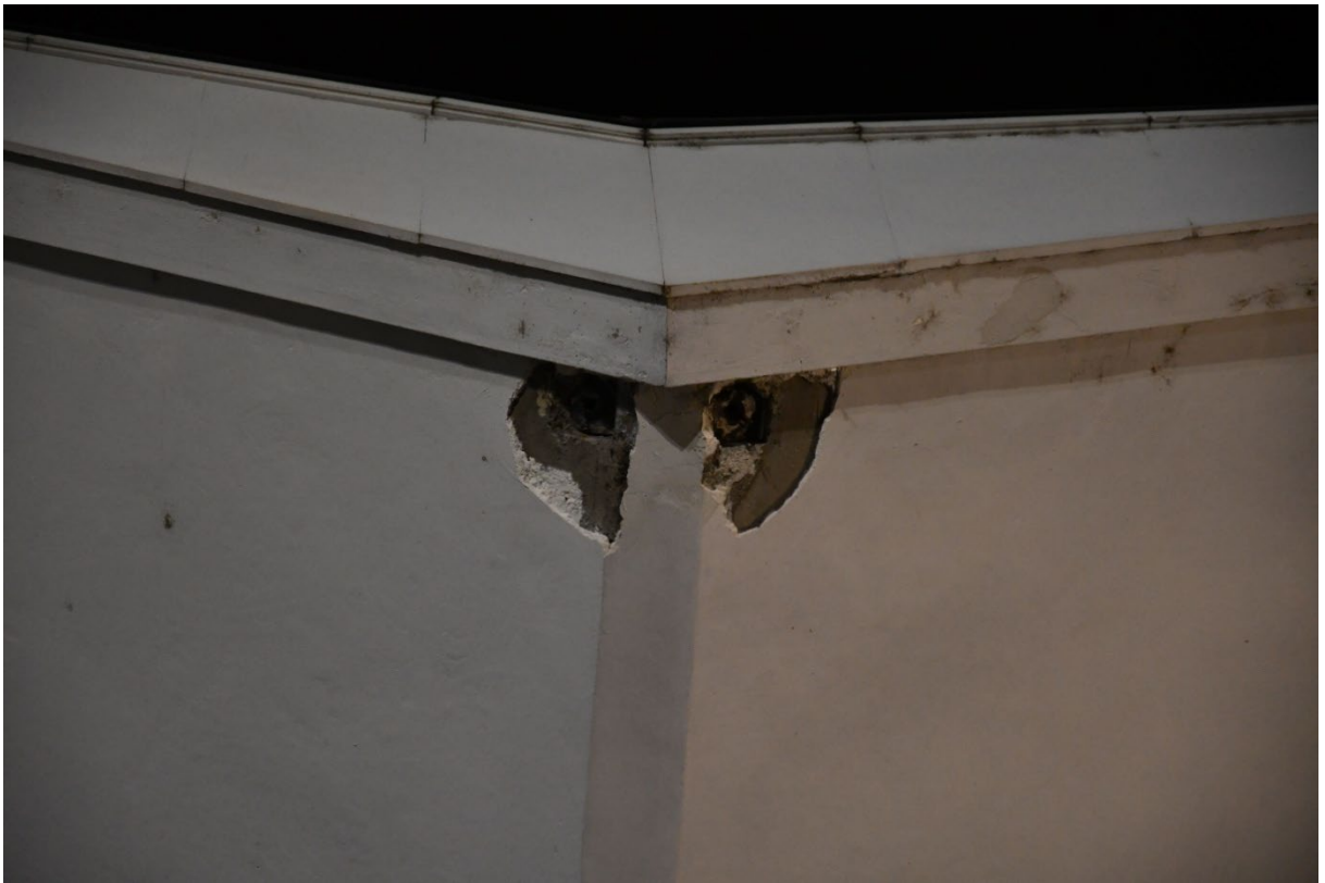
Фот.бр.17: Ближи изглед отвора за анкерисање затега за кровну конструкцију.
