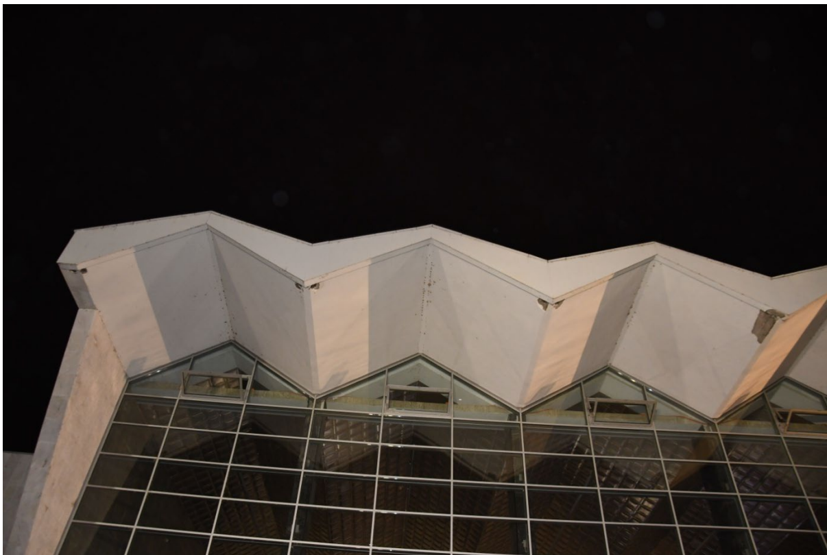
Фот.бр.13: Шири изглед отвора за анкерисање затега за кровну конструкцију.
