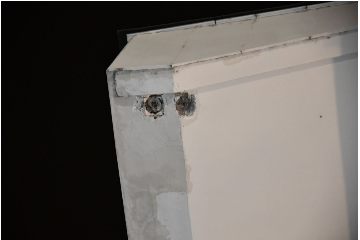
Фот.бр.15: Ближи изглед отвора за анкерисање затега за кровну конструкцију.
