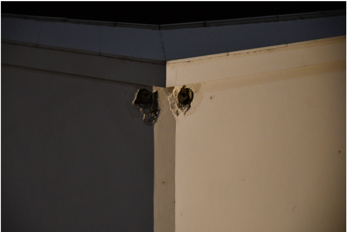
Фот.бр.21: Ближи изглед отвора за анкерисање затега за кровну конструкцију.
