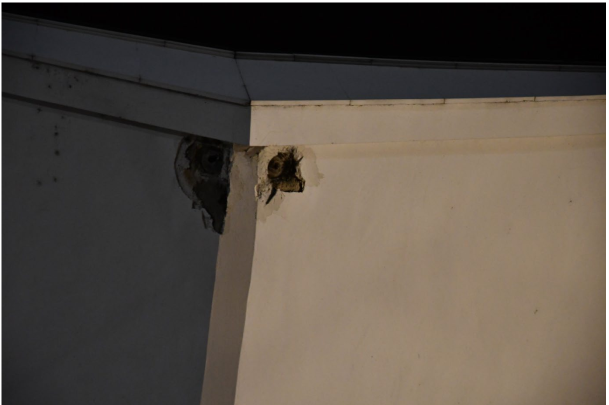
Фот.бр.20: Ближи изглед отвора за анкерисање затега за кровну конструкцију.
