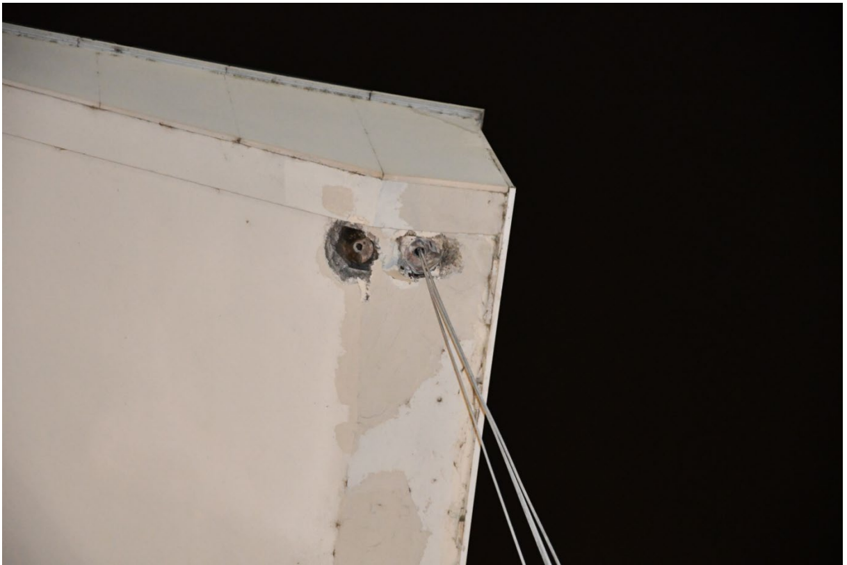
Фот.бр.23: Ближи изглед отвора за анкерисање затега за кровну конструкцију.
