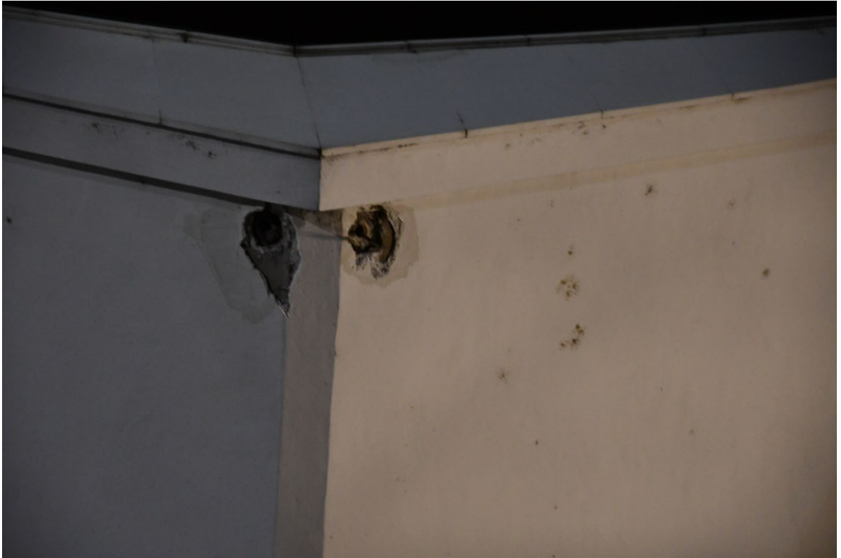
Фот.бр.19: Ближи изглед отвора за анкерисање затега за кровну конструкцију.
