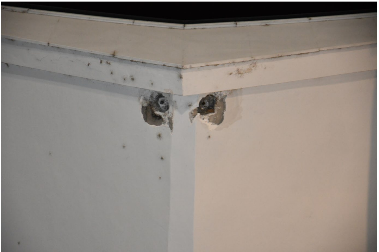
Фот.бр.16: Ближи изглед отвора за анкерисање затега за кровну конструкцију.
