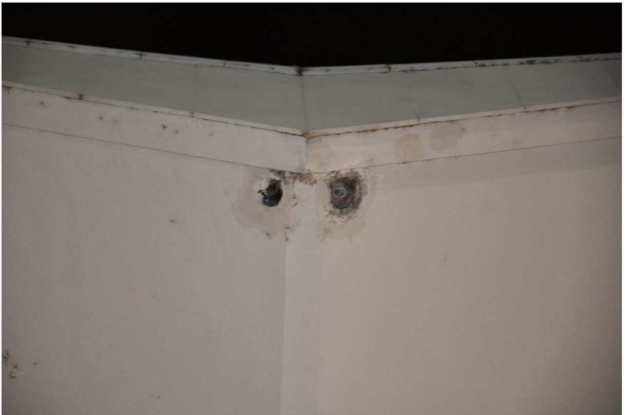
Фот.бр.22: Ближи изглед отвора за анкерисање затега за кровну конструкцију.
