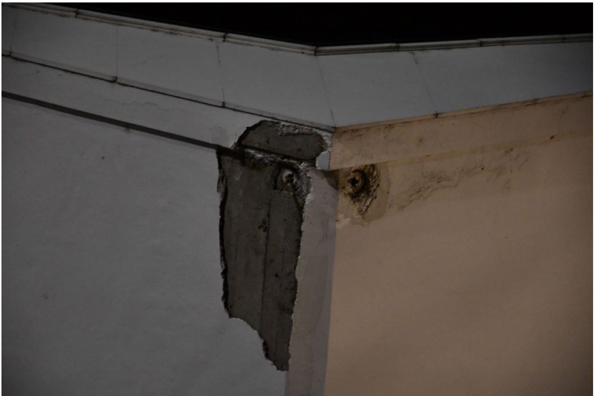
Фот.бр.18: Ближи изглед отвора за анкерисање затега за кровну конструкцију.
