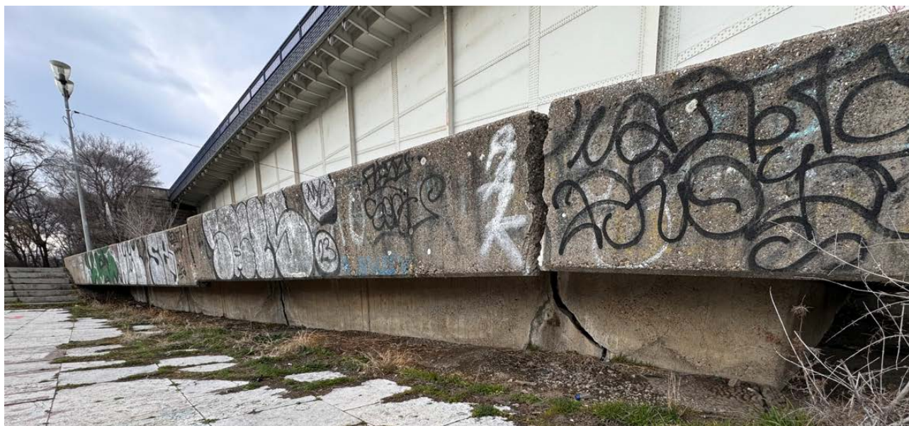
Слика 16 - Евидентирана оштећења ивичних зидова Платоа 2
