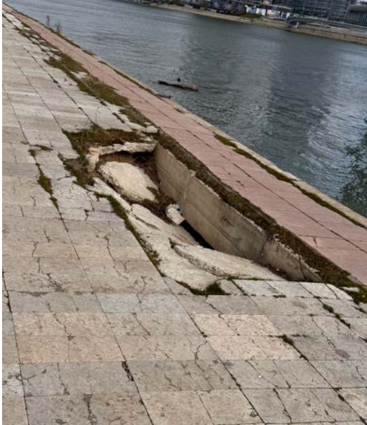
Слика 9 - оштећење поплочања и подложних слојева
